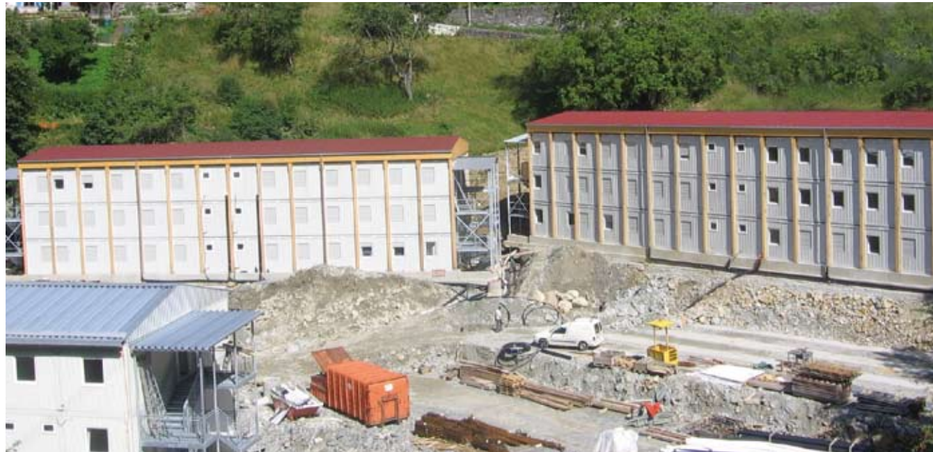
Строительная площадка электростанции Nantes de Drance (CH)
