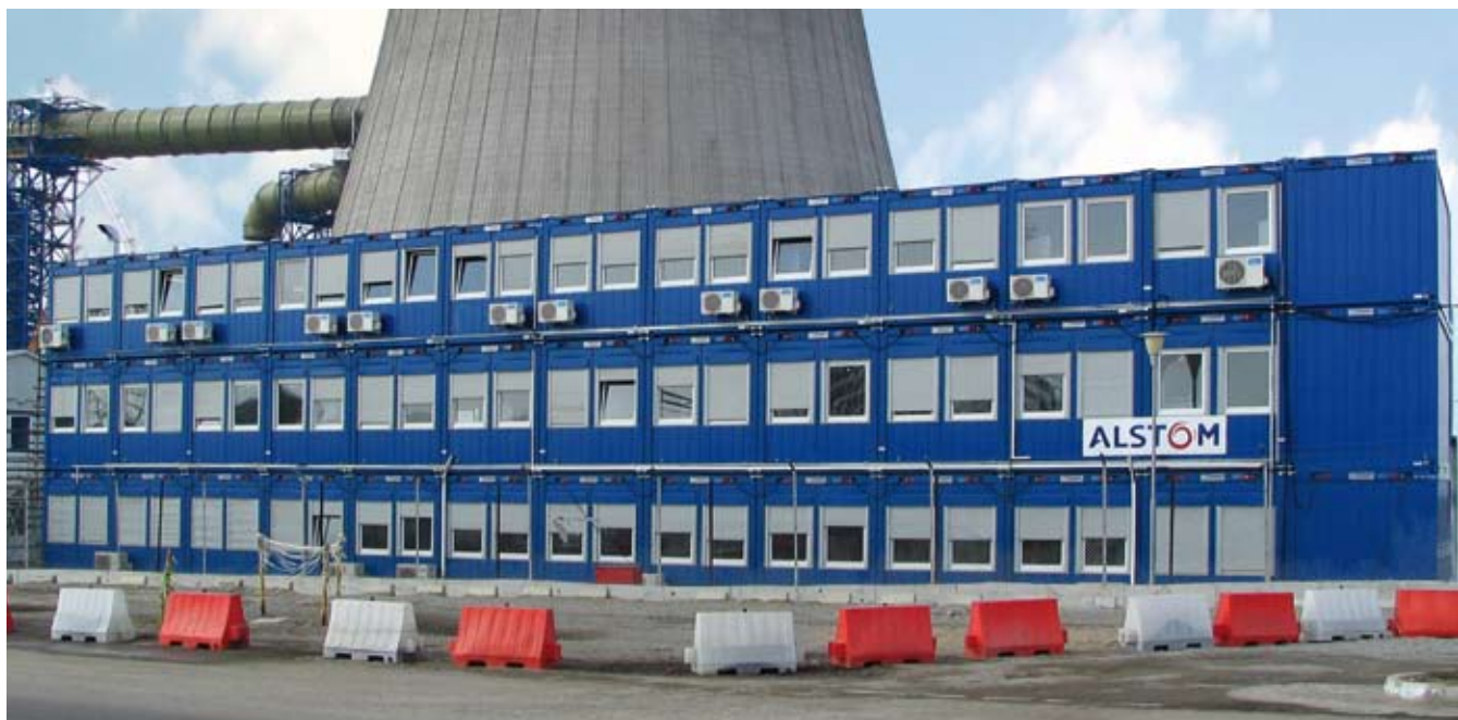
Строительство электростанции Galabovo (BG)
