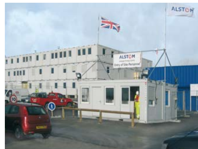
Строительство электростанции Plymouth (GB)
