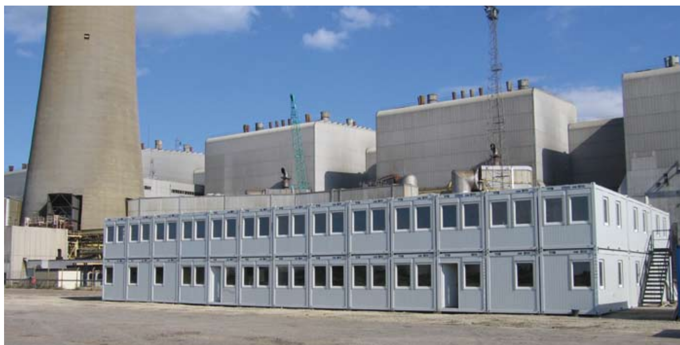
Строительство электростанции Isle of Grain (GB)
